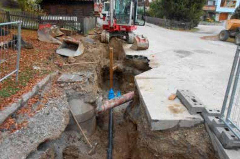
bestehende Gehsteig verbreitert. Zudem wurde begonnen die Hauptwasserleitung von der Burg abwärts, welche noch aus Zementmörtelrohren besteht, auszutauschen. Die noch verbleibende Zementmörtelwasserleitung wird heuer ausgetauscht und durch eine neue ersetzt. Nach dem Austausch der Einbauten wird die Asphaltdecke von der Burg bis zur Fleischbrücke abschnittsweise saniert. Die Treppenanlage zum Gemeindeamt, sowie zum Brunnenplatz wird im Anschluss neu hergestellt.
